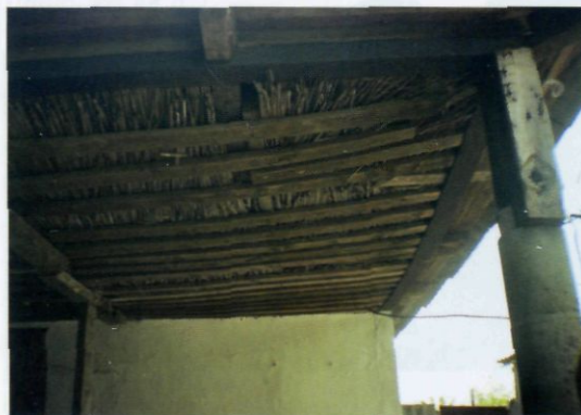
(фото 18). Фрагмент потолка веранды (дерево, камыш). 1970-е гг. XXв. (архив ФЭЭ КГУКИ 2004г.).
